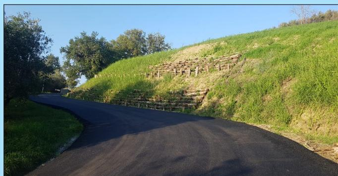
anche lungo via Coriano. Su via Ca' Menghi abbiamo realizzato, come da progettualità approvata - spiega la Sindaca Mirna Cecchini - una nuova paratia in cemento armato e una palificata in legno, aggiungendo poi la profilazione delle scarpate e l'eliminazione della vegetazione in esubero. Inoltre è stata predisposta una nuova barriera di sicurezza in acciaio e il nuovo manto d'usura in conglomerato bituminoso insieme al rifacimento della segnaletica orizzontale e verticale".
